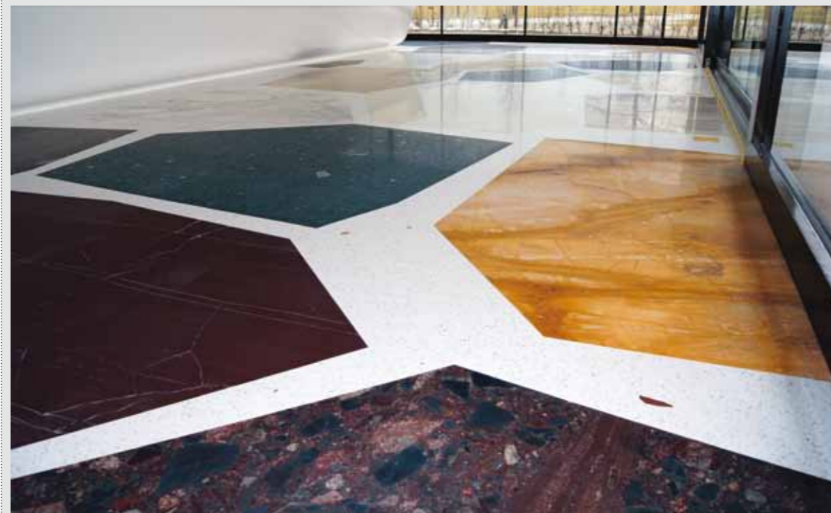
Vor Ort geschliffener Natursteinbelag.
